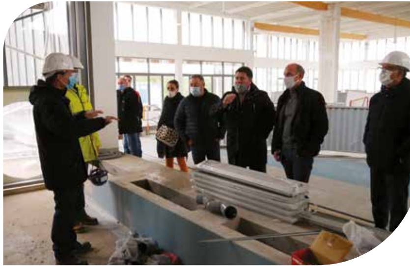
La visite du centre aquatique : explications de l'avancée des travaux.
