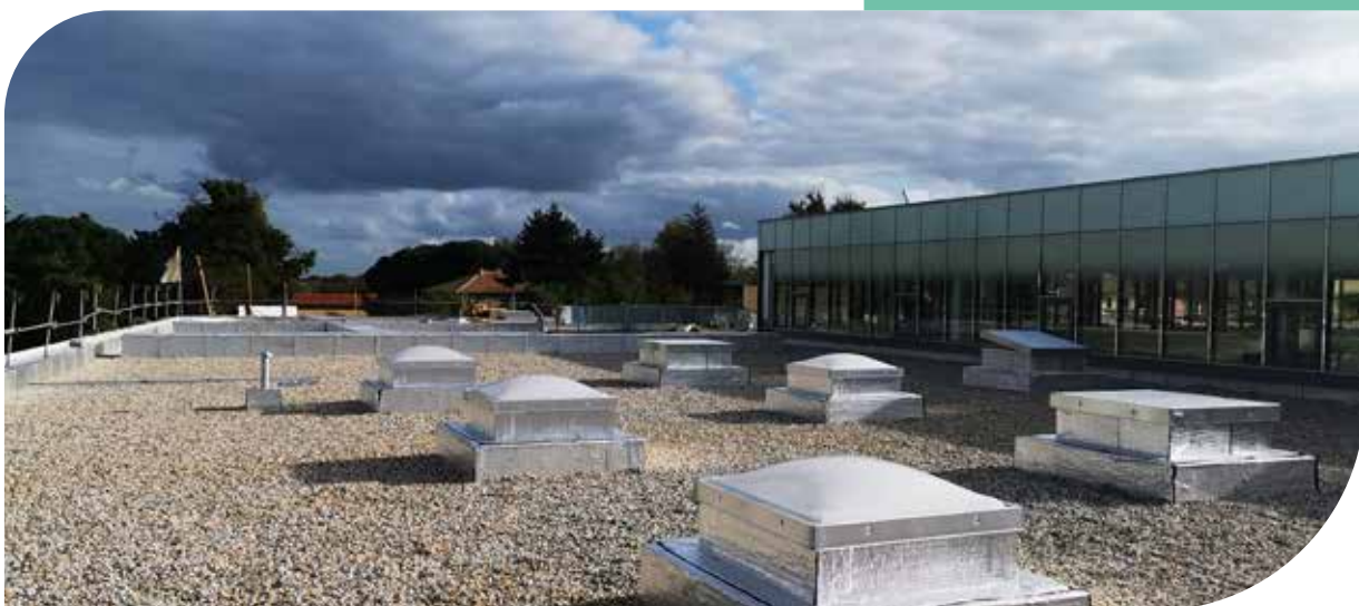
Le toit du Centre aquatique.
