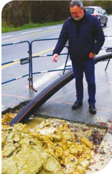
Pierre Cotsas, vice-président de la CDC, avenue d'Aquitaine, détaillant la complexité des travaux.
