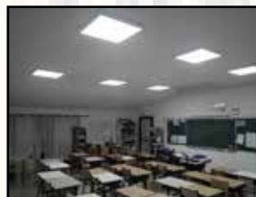
Remplacement luminaires LED
