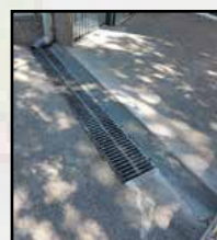
Réalisation d'un système de dévoiement d'eau
