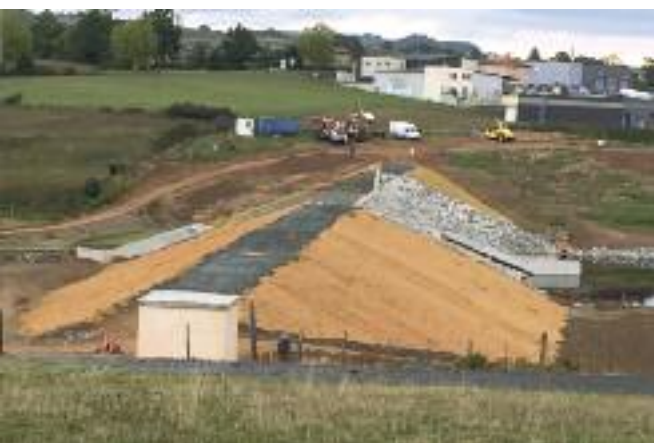
Le barrage écrêteur de crues sur la Turdine Septembre 2017
