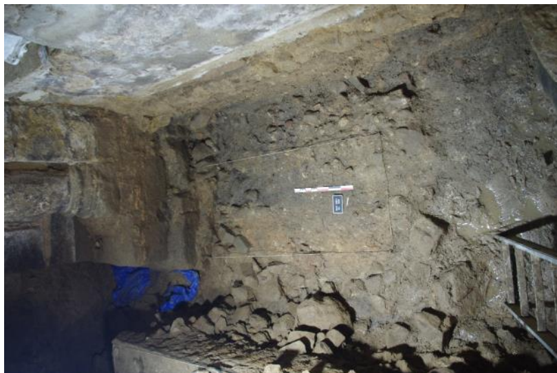
▲ Photo 2 : Sondage 2 dans la chapelle. Au fond, le pilier sud-est avec son élévation de grès marron et ses fondations imposantes de granite et de roches basaltiques. Ce sondage n'a pas pu être mené à terme pour des raisons de sécurité : sur toute la hauteur de terrassement, n'ont été enlevés que des remblais déposés ici depuis le XVIII e siècle. Les vestiges pourront être atteints l'année prochaine, après le décaissement du sol. Crédit : O. Puel, 2021.
